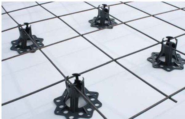
Armatuurkandurite paigutamine
